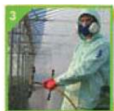
Προστασία κατά τη διάρκεια της εφαρμογής
